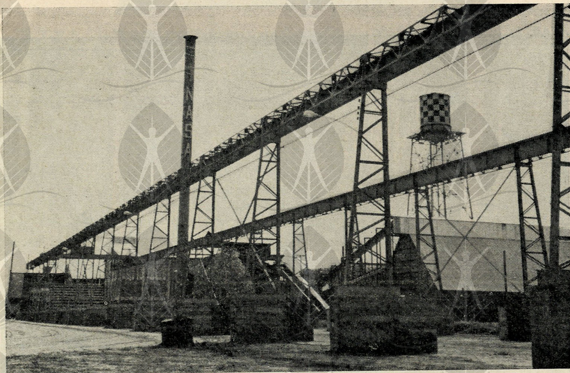
Esta é uma indústria favorecida pela legislação fiscal vigente — INDÚSTRIAS NOVA AMERICA S.A. — INASA. Mun. de Breves, Estado do Pará. — Serraria de alta produtividade, com dispositivos para imunização e secagem artificial. Produzirá 75.000 m 3 /ano de madeira serrada. Na foto, a ponte rolante de carregamento de madeira
