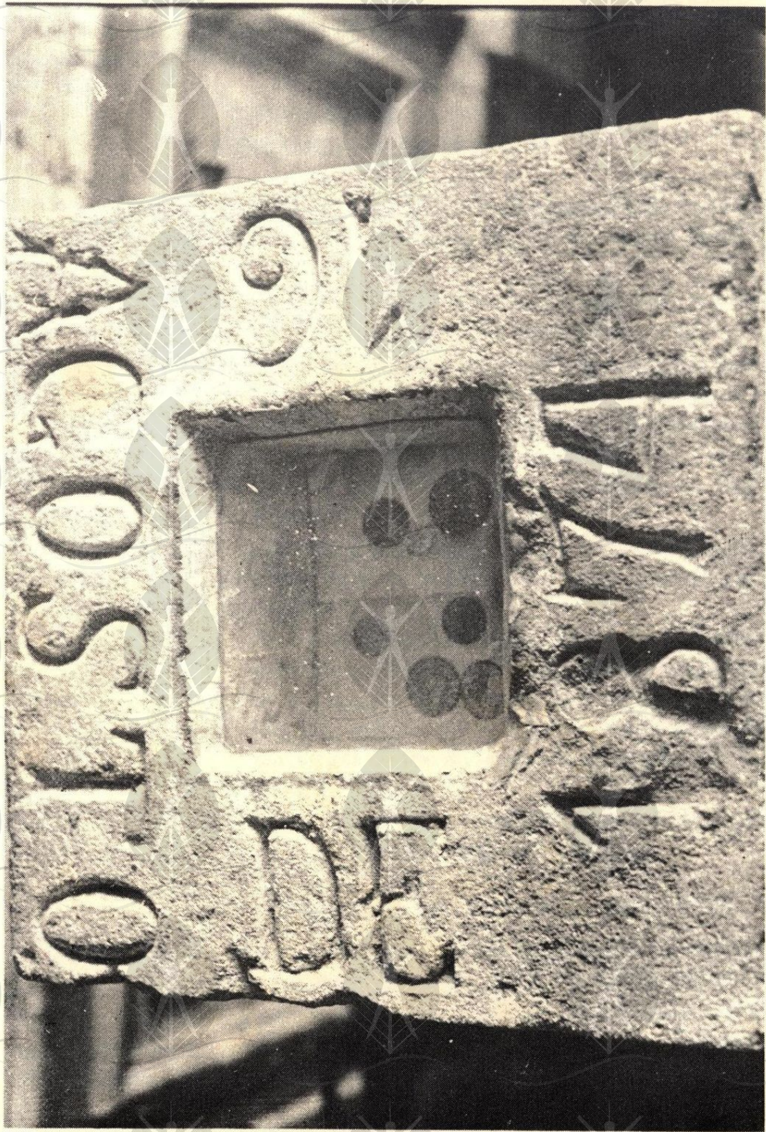
Pedra Fundamental do Hospital colocada no terreno da Praça Uruguaiana com as moedas que encerra.
