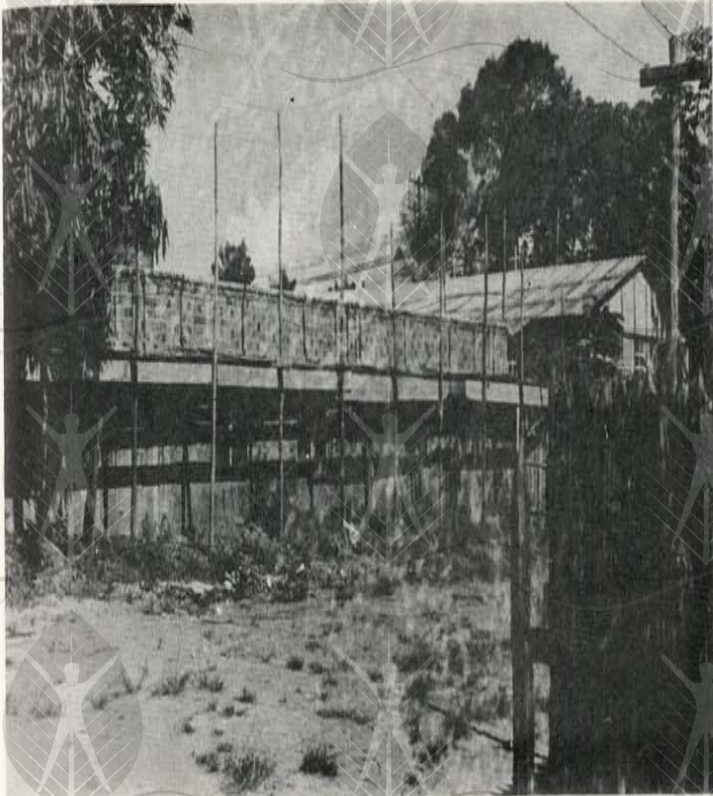
Aspecto da construção do Colégio N. S. da Conceição Aparecida, na Rua Comendador Alexandre Amorim, bairro dos Tocos. Foto de 1944.
