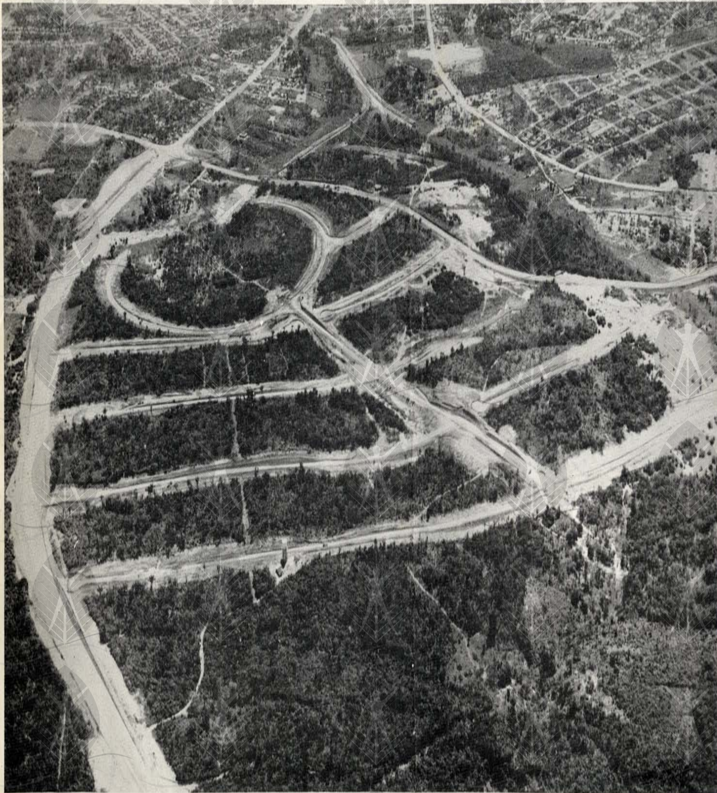
Arruamento do Distrito Industrial.
