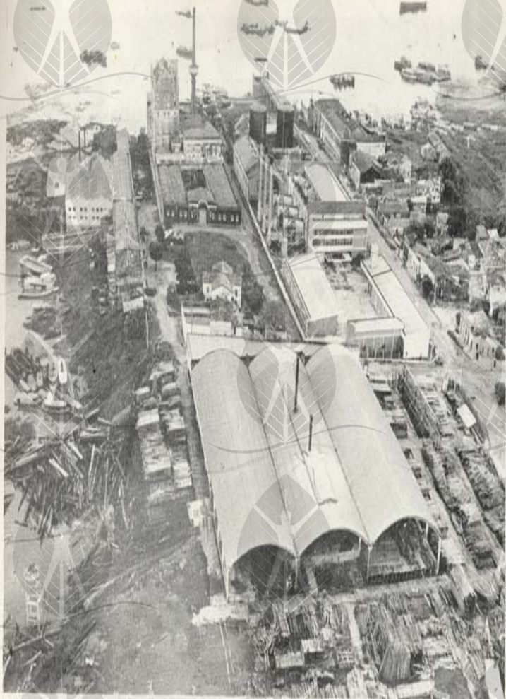
Vista aérea do Plano Inclinado, vendo-se em primeiro plano a Serraria da Cianorte. Ao fundo a Fábrica de Cerveja Miranda Corrêa.
