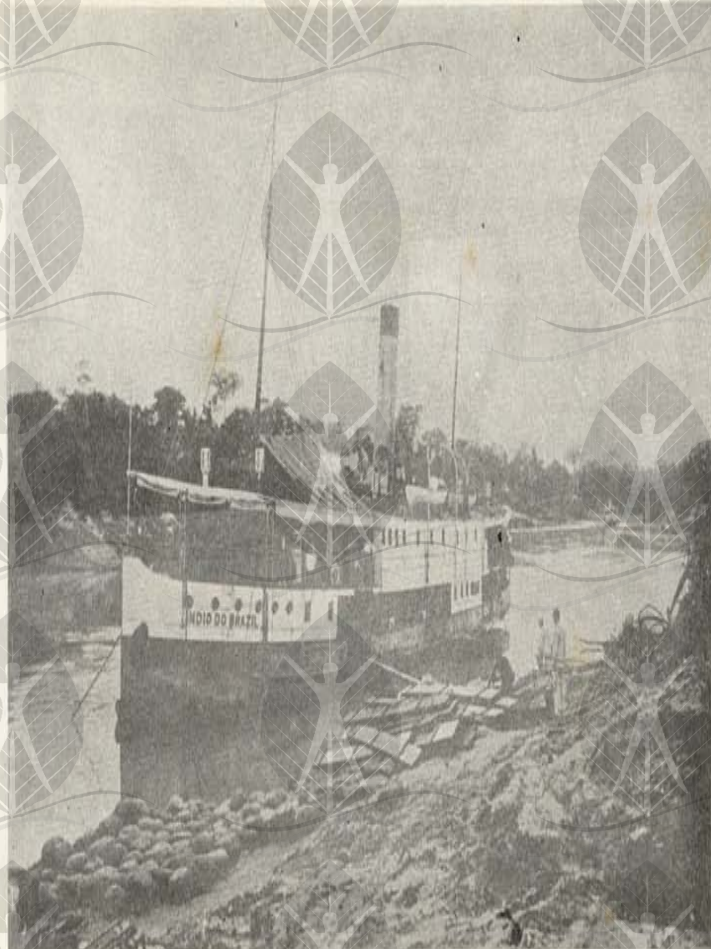
Vapor "Índio do Brasil", de propriedade da Companhia do Amazonas, era seu comandante o sr. Antonio Gonçalves Bandeira. Tinha a capacidade para 220 toneladas, 160 pés de comprimento e 33 de largura.
