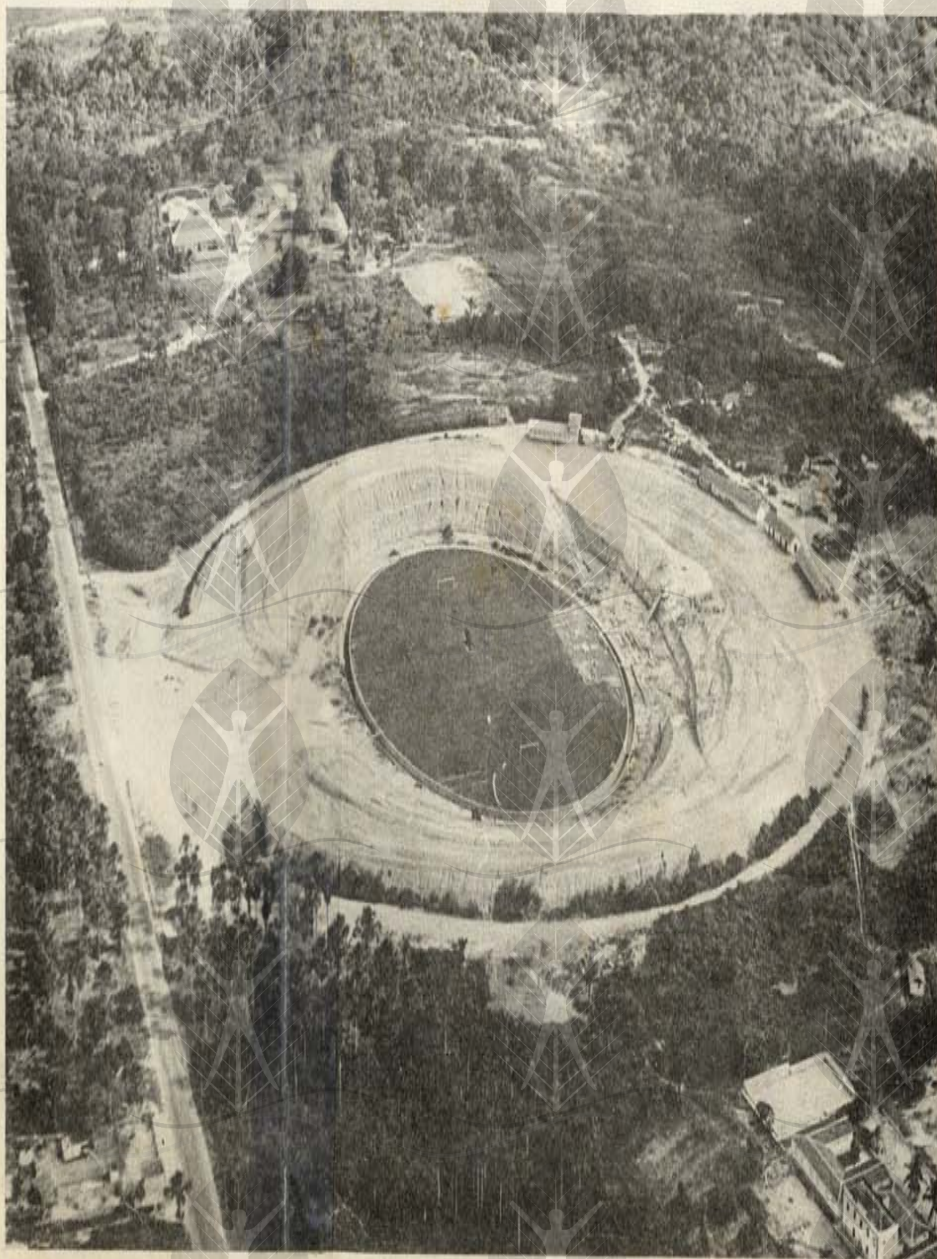
Construção do Estádio Vivaldo Lima.
