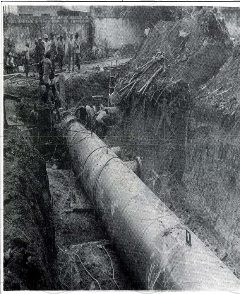
Obras de ampliação do sistema
