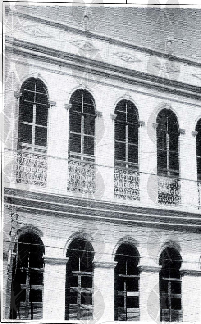
Restauração do prédio do antigo DAE
