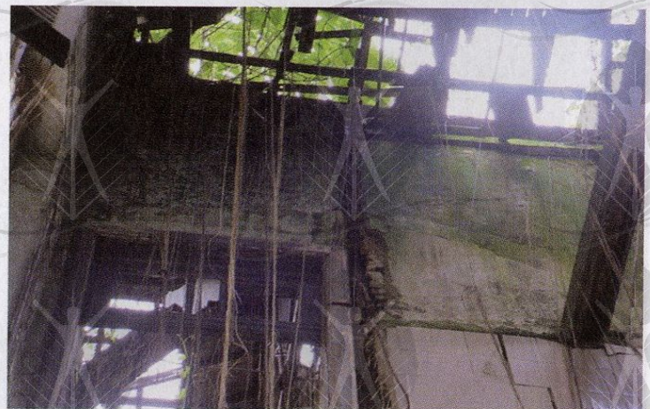
Interior do imóvel. Vão da escada de acesso ao pavimento superior apresentando desabamento de parte da escada, forro e cobertura.
