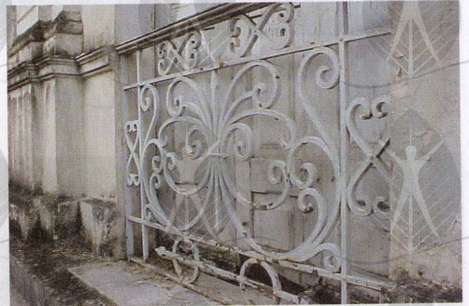
Elementos da fachada. Guarda-corpo em ferro, presentes na fachada externa.
