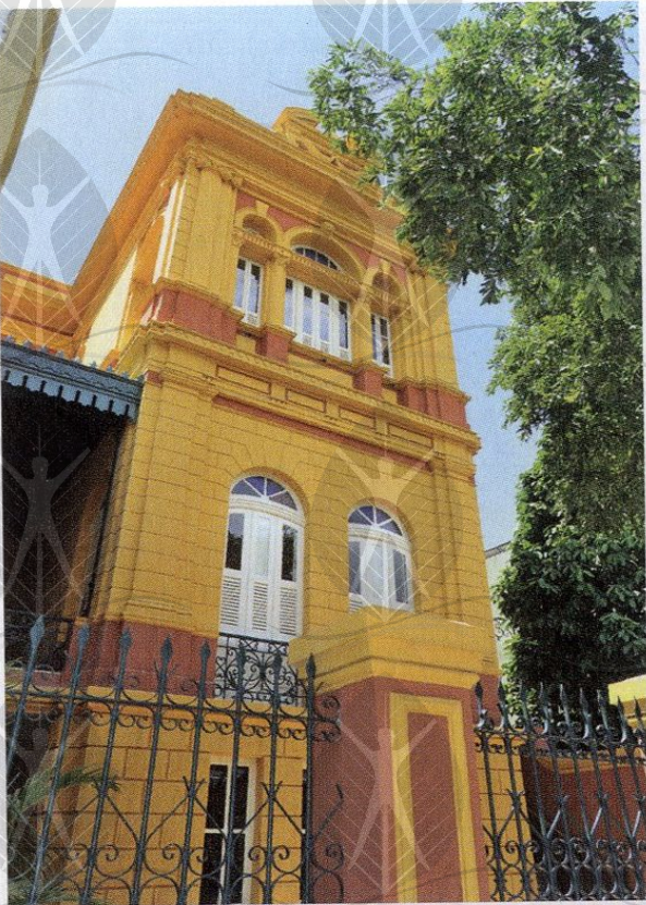
Fachada vista pelo ângulo esquerdo.
