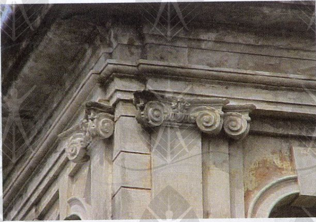
Elementos da fachada. Presença de capitel coríntio nas colunas externas.
