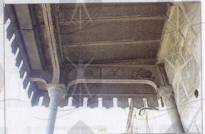
Elementos da fachada. Pilares, vigas, forro e lambrequim em ferro, na varanda frontal.
