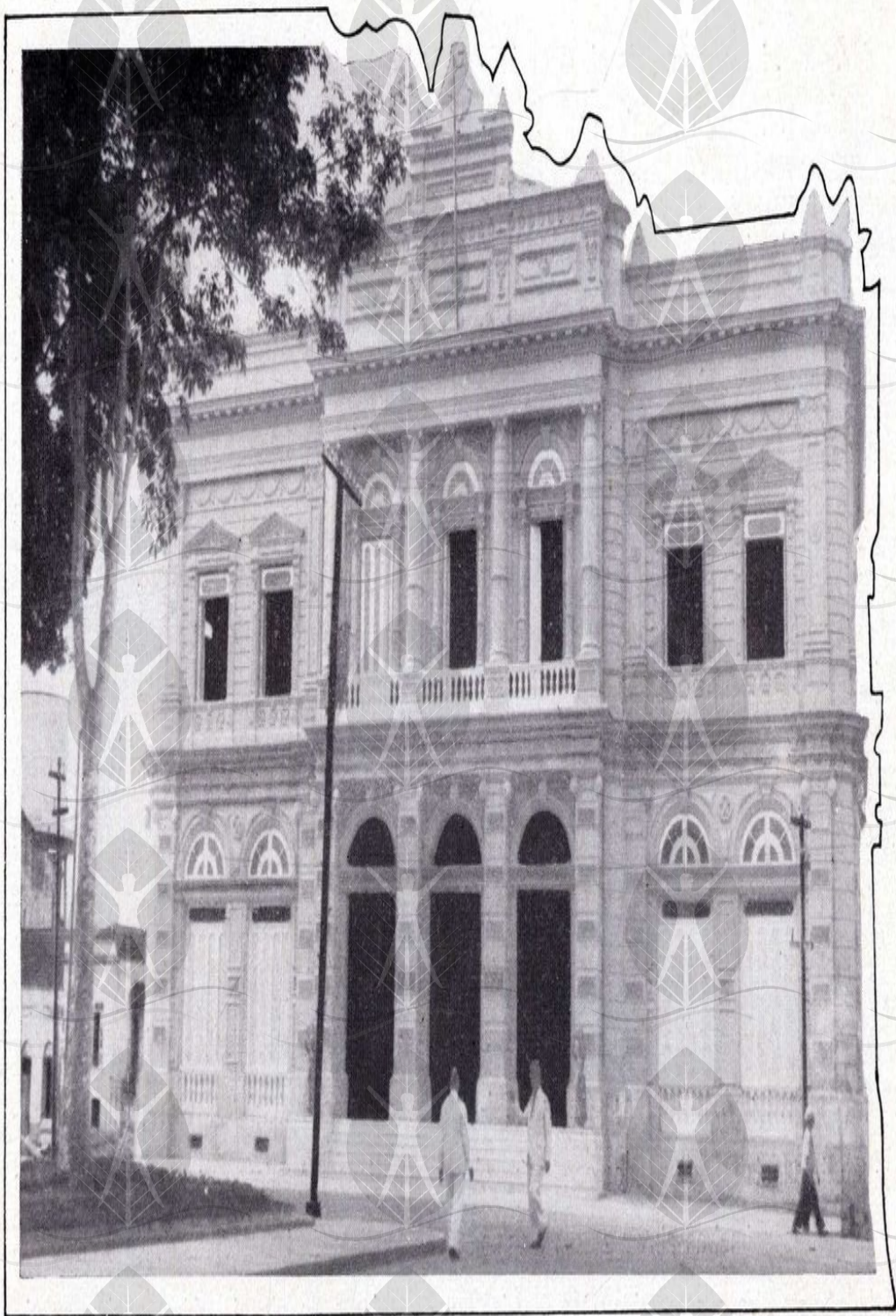
O PALÁCIO RIO BRANCO, concluído na administração Alvaro Maia e inaugurado na manhã de 7 de Setembro de 1938
