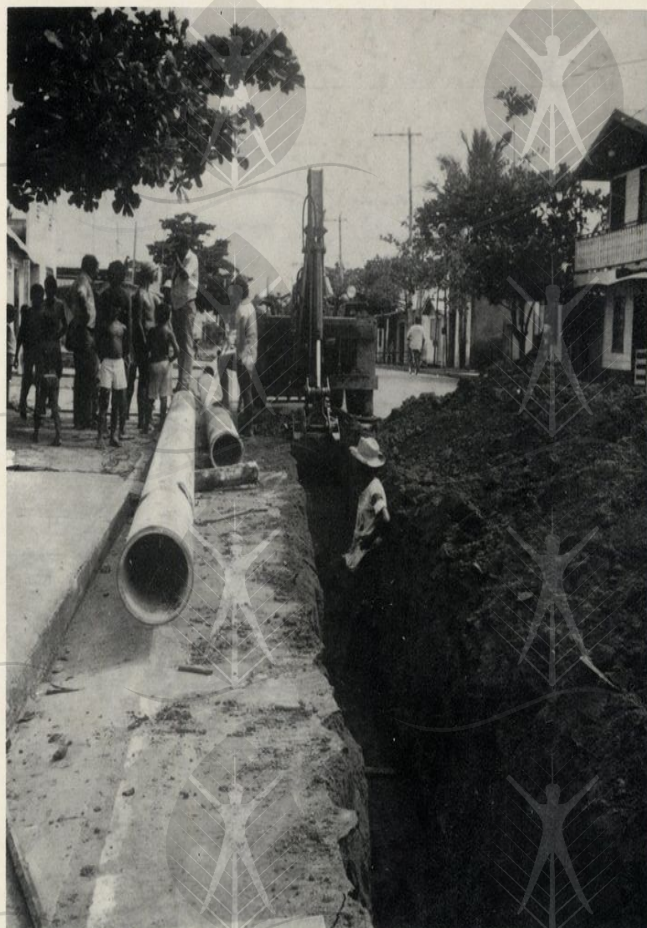
Ampliação da rede de abastecimento de água, em Manacapuru.
