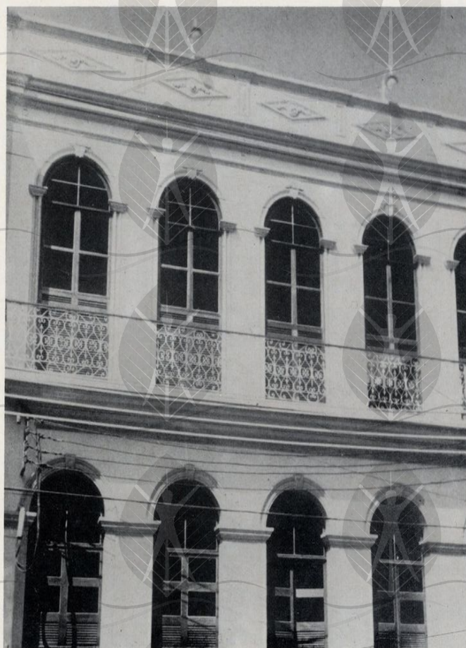
Restauração do prédio do antigo D.A.E. à rua Miranda Leão, nº 42.
