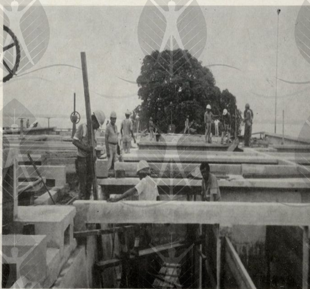
Obras de reforma na Estação de Tratamento de Água/1988.
