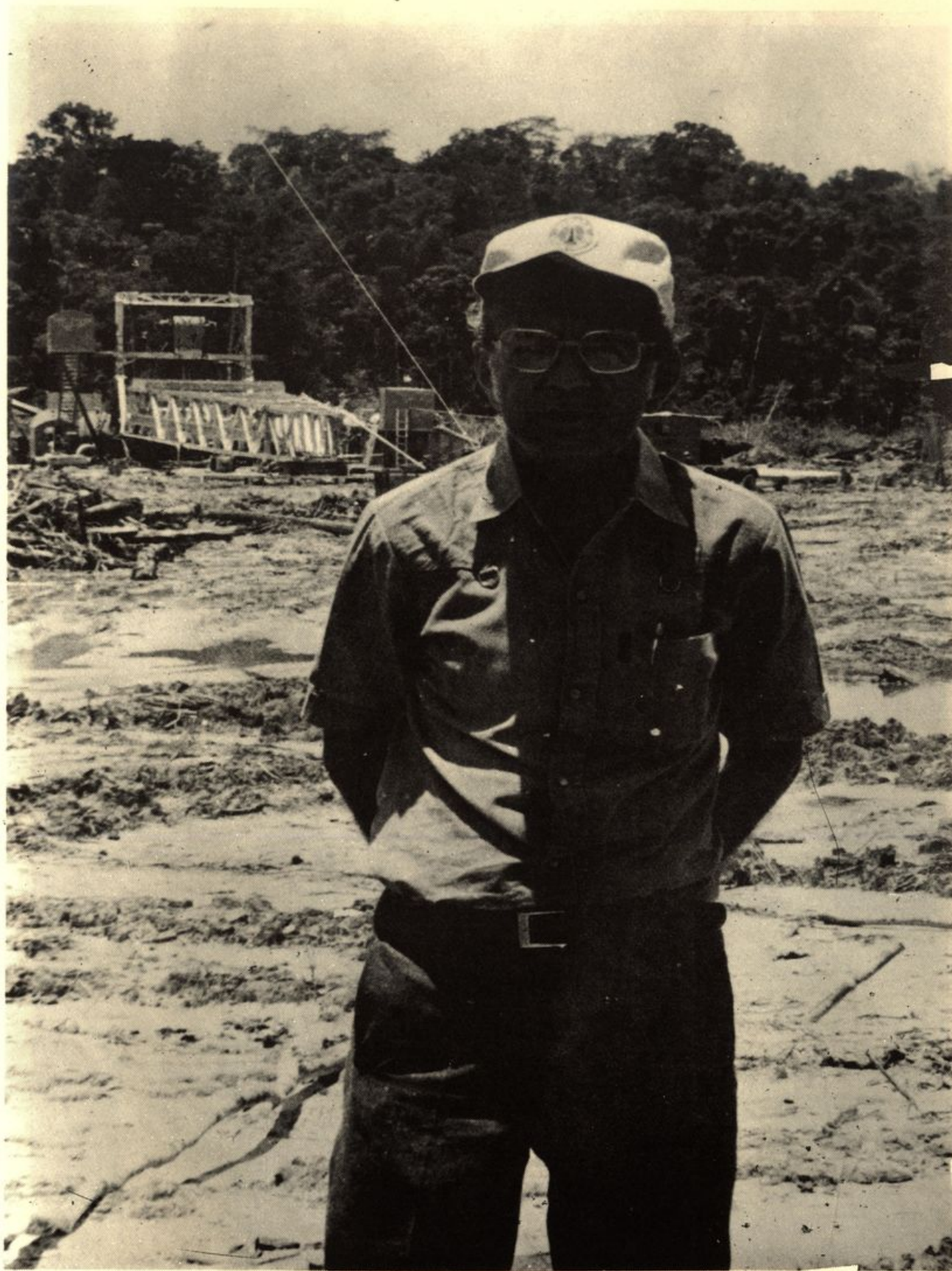
O autor na área de montagem da torre da sonda SM-2.
