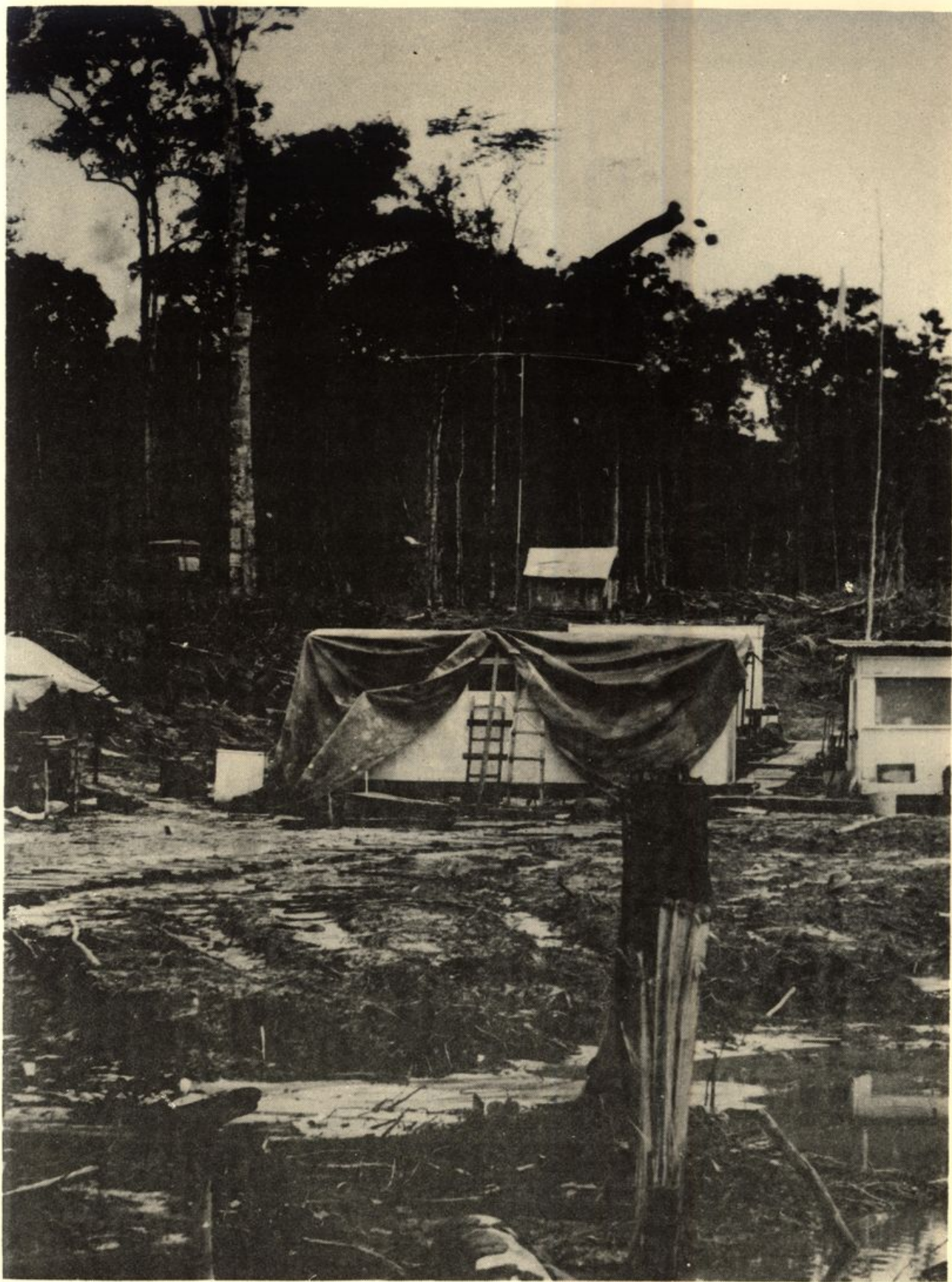
Casas pré-fabricadas do acampamento e estação de rádio-comunicação.
