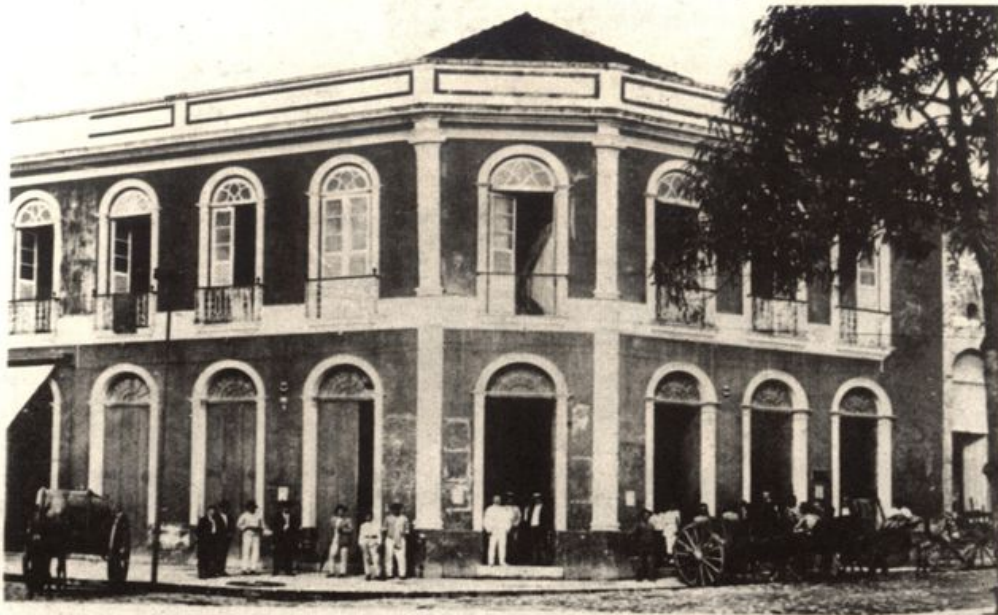
Avenida Eduardo Ribeiro, 28 e Rua Quintino Bocayuva, 1
