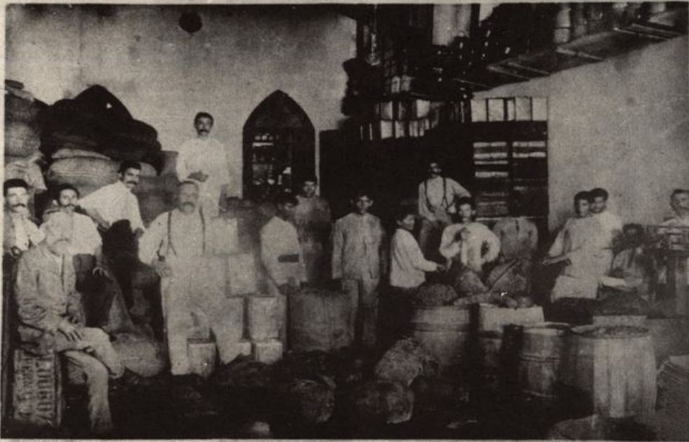
Vista interior do Depósito
