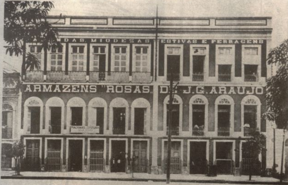
Fachada - Avenida Eduardo Ribeiro, 14 a 16
