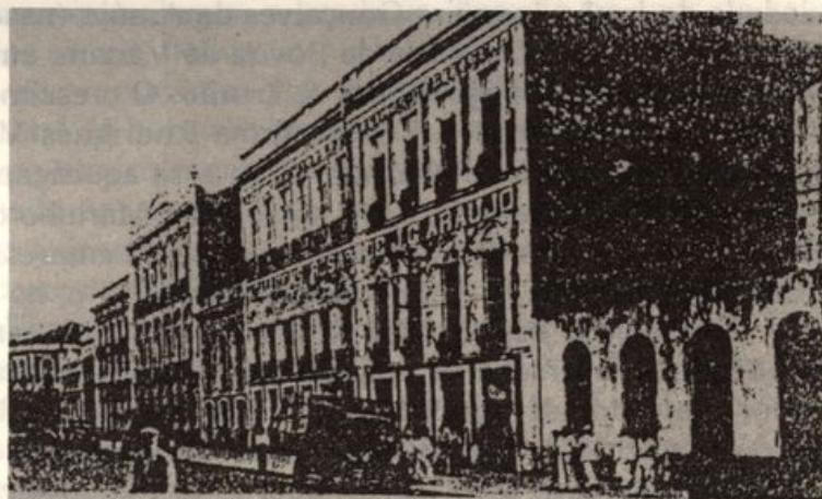
A fachada do prédio em 1896. A reforma foi feita em 1940
