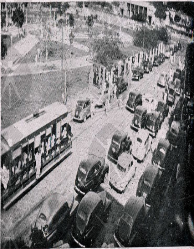
UM TRECHO DA RUA SIMÃO BOLIVAR — AO LADO A PRAÇA DA SAUDE
