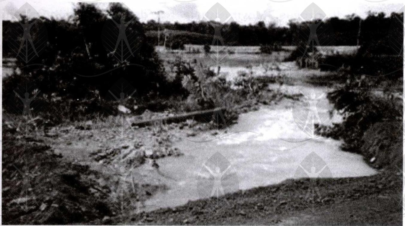
Figura 07 - Rompimento de barragem de área de exploração mineral, causando poluição do rio.
