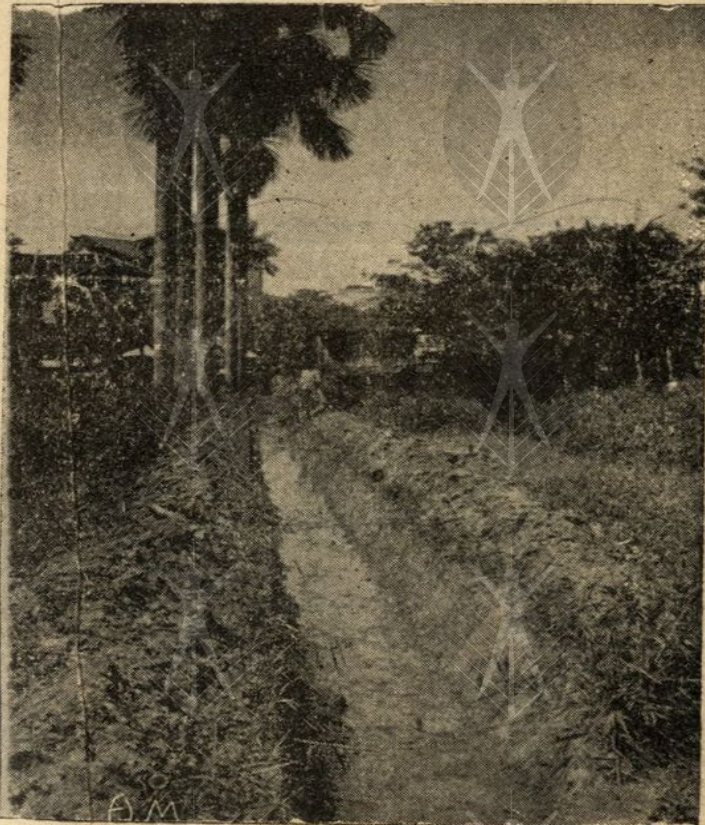
...secco após a abertura da valla
