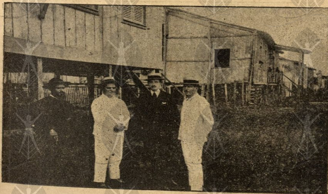
Systema de construcção em Remate de Males, com altura para enfrentar a enchente.
