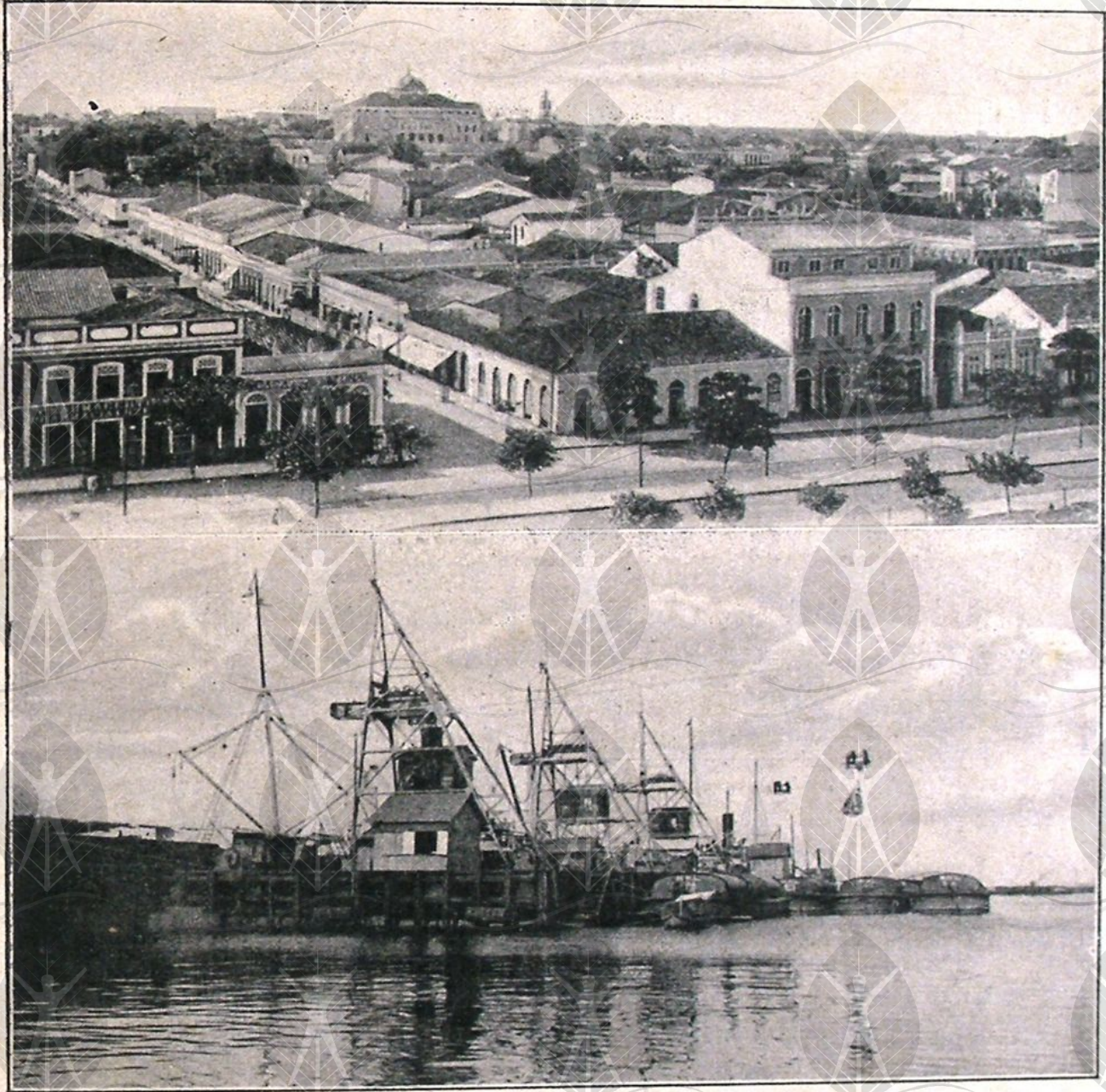
Une vue de Manaus. — Les docks de la Manais Harbour et les cableways électriques.
